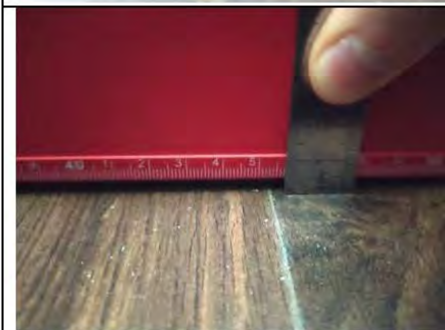
Фото №15. Измерения уровня напольного покрытия в спальне.
