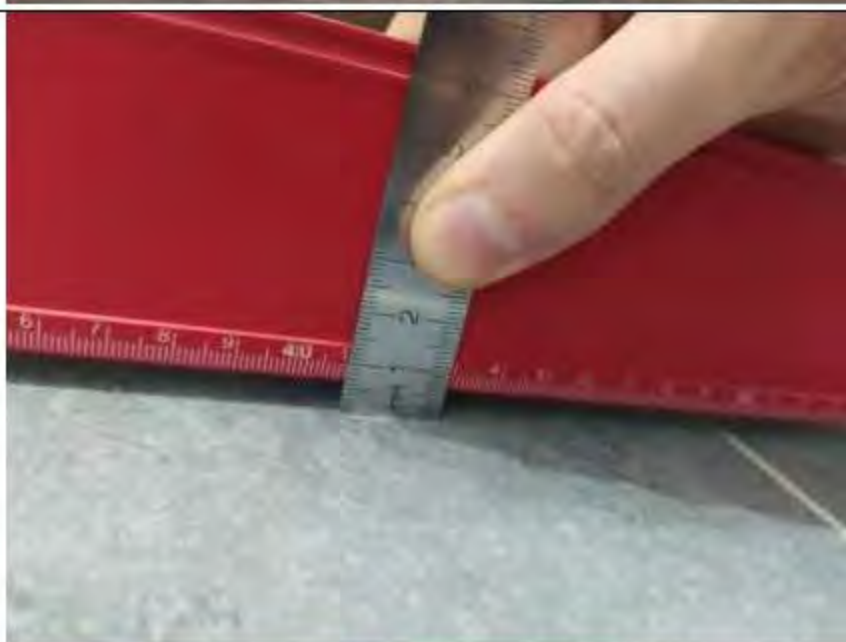
Фото №17. Измерения уровня напольного покрытия в прихожей.
