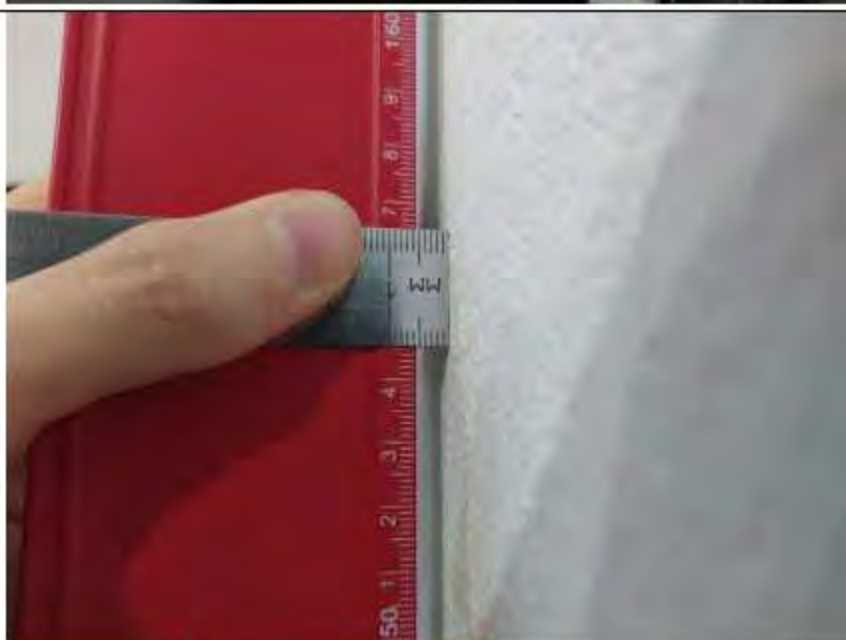
Фото №8. Измерения уровня стен в кухне.
