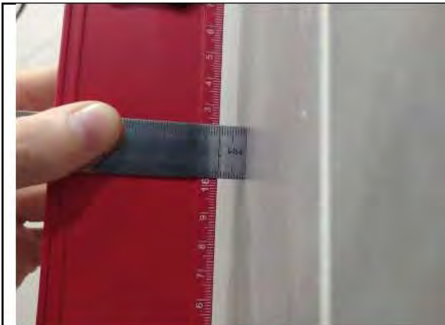
Фото №13. Измерения уровня стен в ванной комнате.
