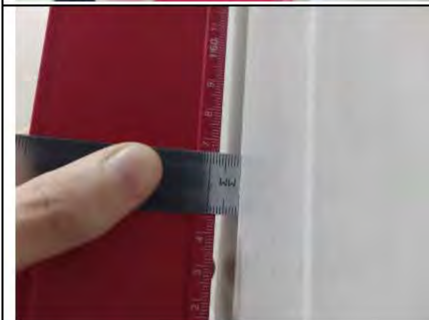
Фото №12. Измерения уровня стен в санузле.
