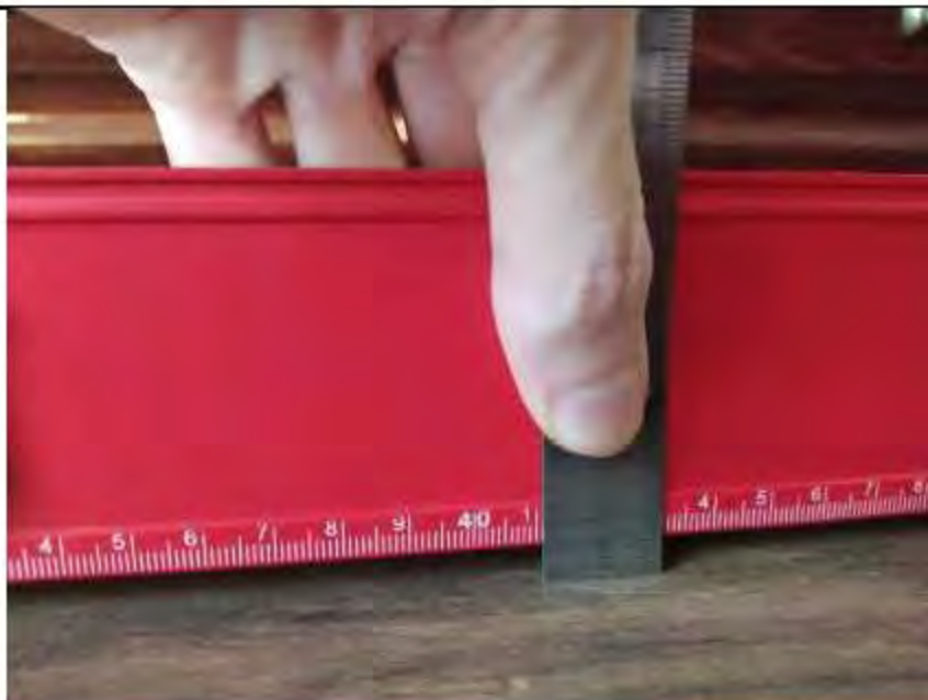
Фото №16. Измерения уровня напольного покрытия в гостиной.
